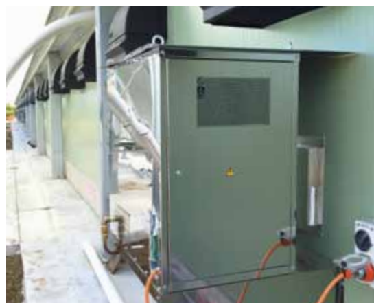
Montáž vně budovy
