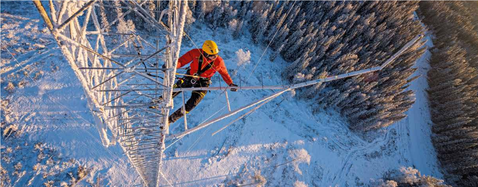
Telekomunikační věž, Švédsko ■ Foto: Pavel Nesvadba
